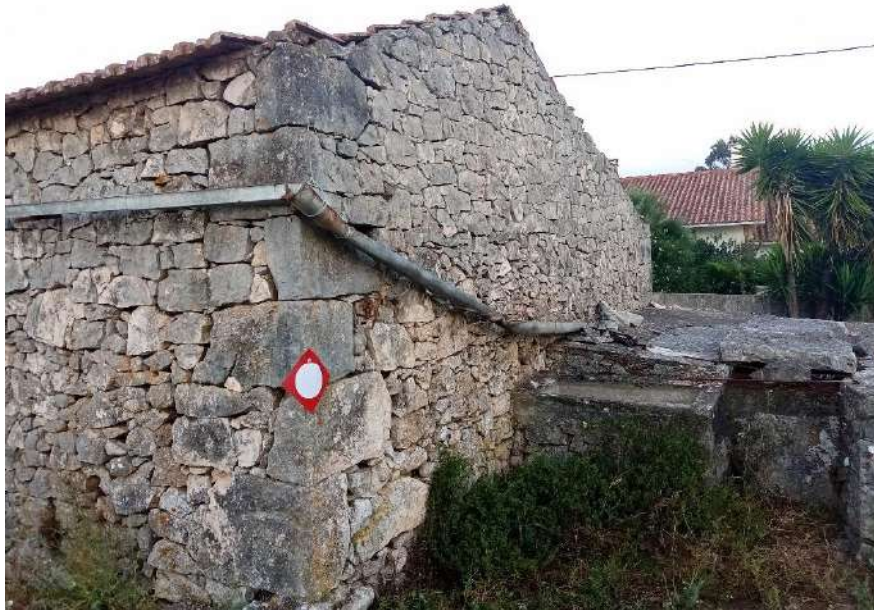
Figura 13: Antiga habitação com cisterna alimentada por caleira.
